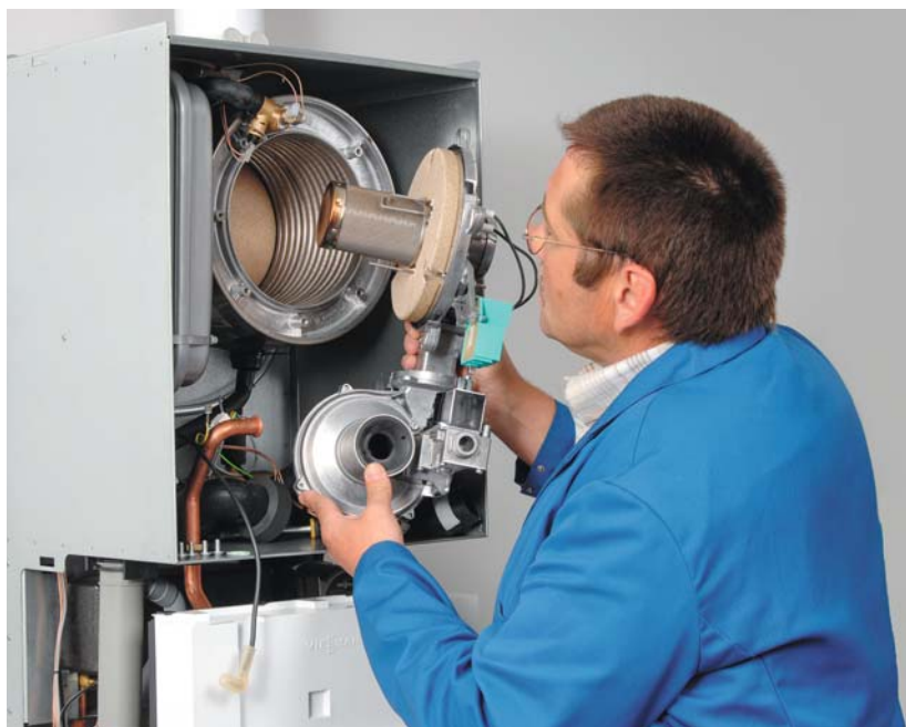
Ein Blick in den Brennraum und anschließend werden neue Dichtungen als sogenanntes Hilfsmaterial eingesetzt
